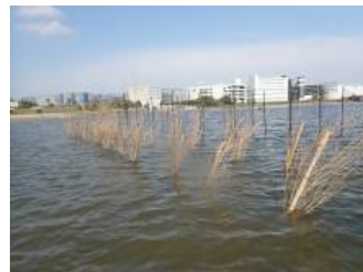
ヒビ・支柱建て完了
